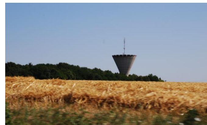
Photo 163. Vue sur le château d'eau au nord de la commune
